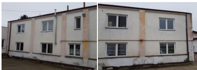
Elewacja W (skrzydło południowe)
